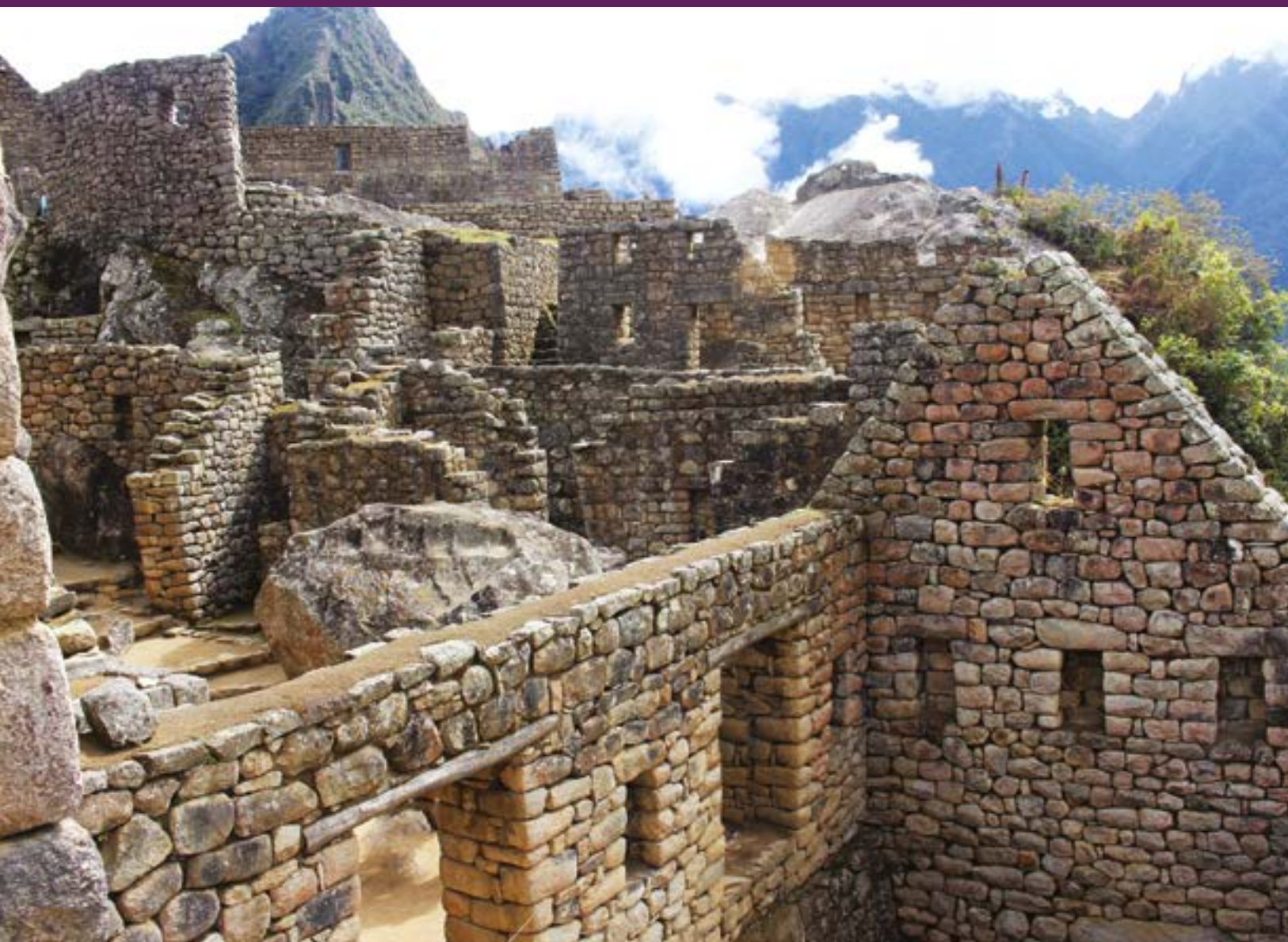
Construcción de casa inca, Perú.
