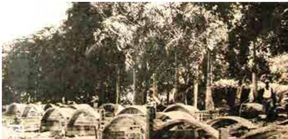
Figura 1. Foto storica degli anni '60 che mostra i modelli in scala di diverse geometrie di volte, a botte utili all'insegnamento della tecnica alle maestranze cubane.
