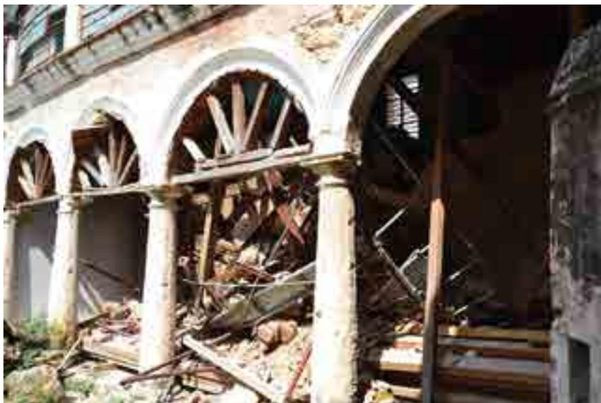
Figura 5: Crollo del solaio del piano primo nella galleria del primo chiostro adiacente al *zaguán*.
