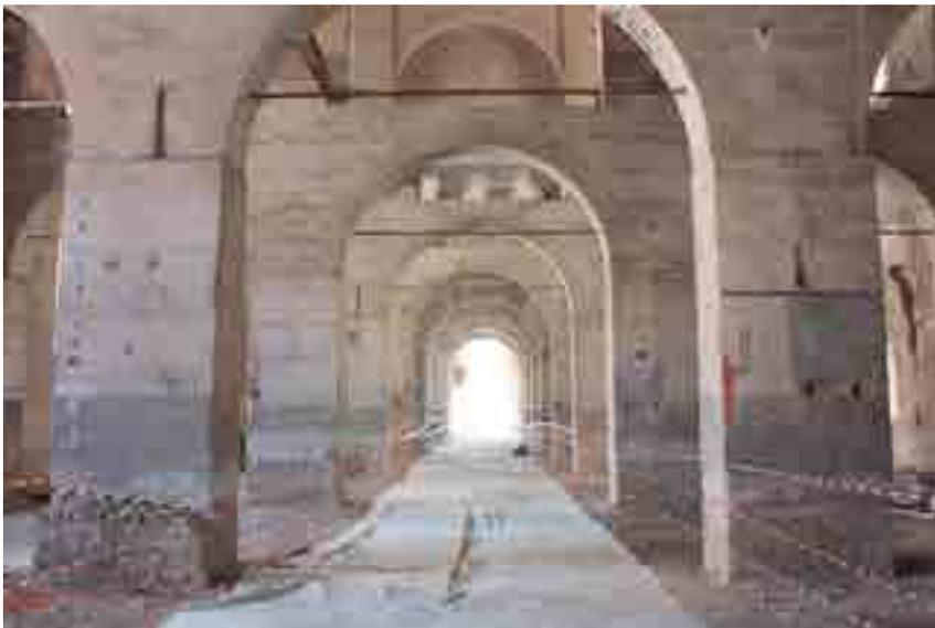
Figura 6. Setti trasversali con aperture ad arco.
