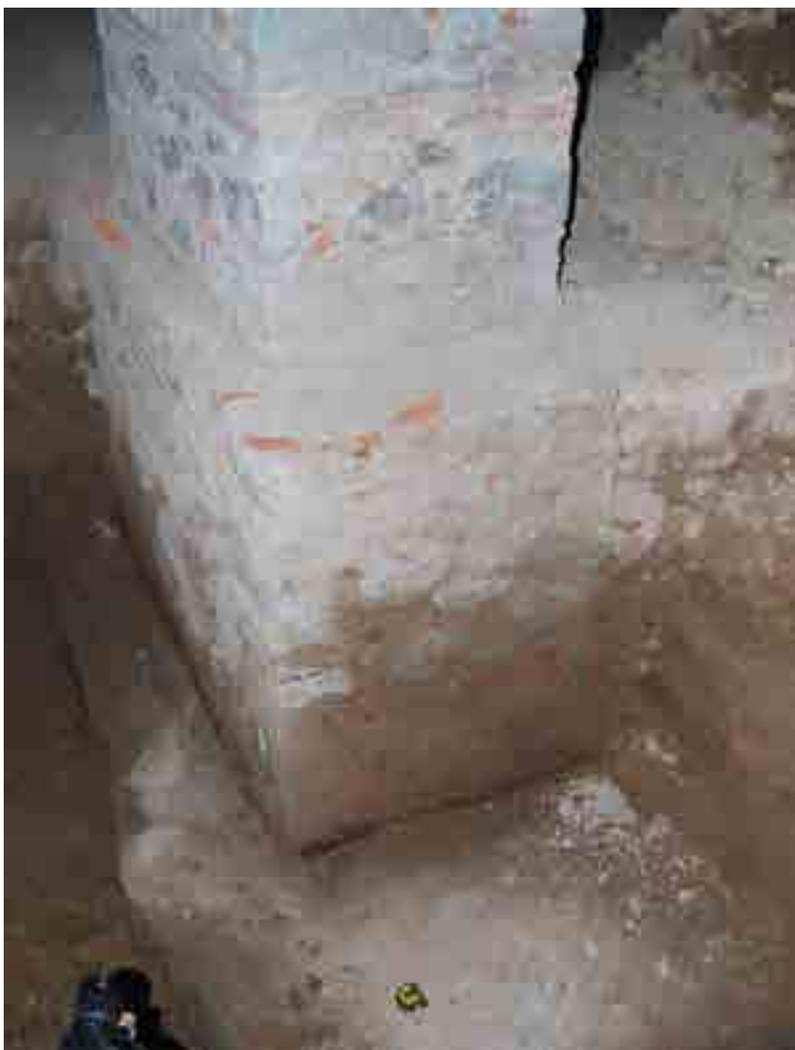
Figura 11. Saggio di fondazione su pilastro interno del setto ottocentesco.
