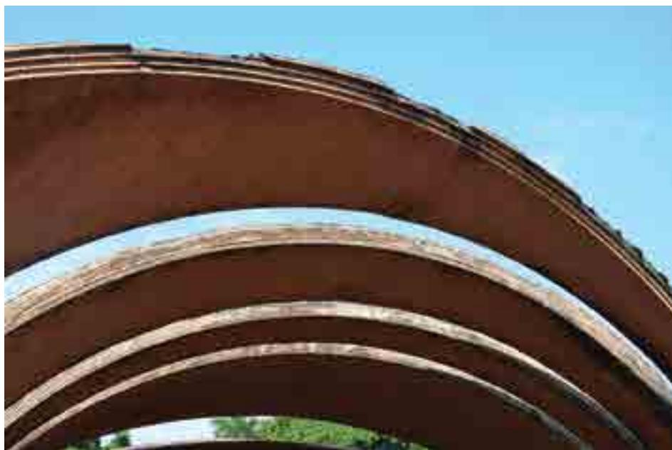
Figura 4. Volte catalane dell'entrata della Scuola di Balletto di Vittorio Garatti: sono visibili le perdite di *rasillas* in estradosso.
