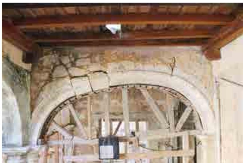
Figura 8. Foto dell'arco nell'angolo Sud-Est nella galleria Sud dove si evidenziano fenomeni di precollasso e scivolamento a cuneo dei conci.
