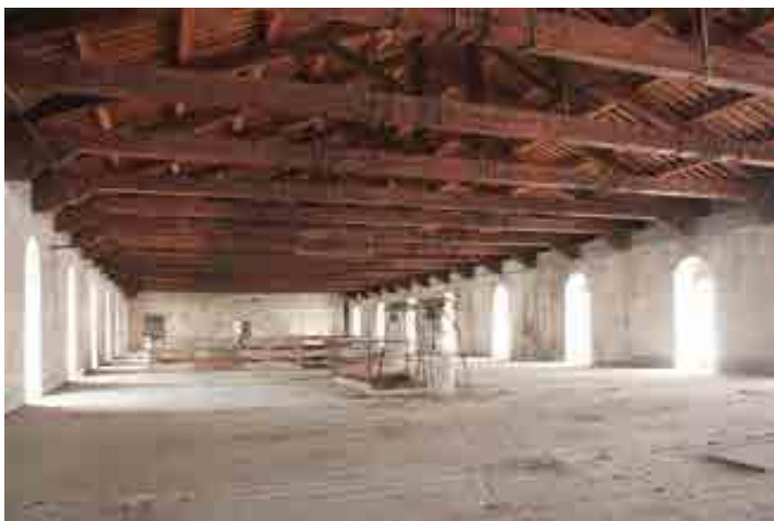
Figura 9. Foto sottotetto dove sono visibili le diciassette capriate in legno.
