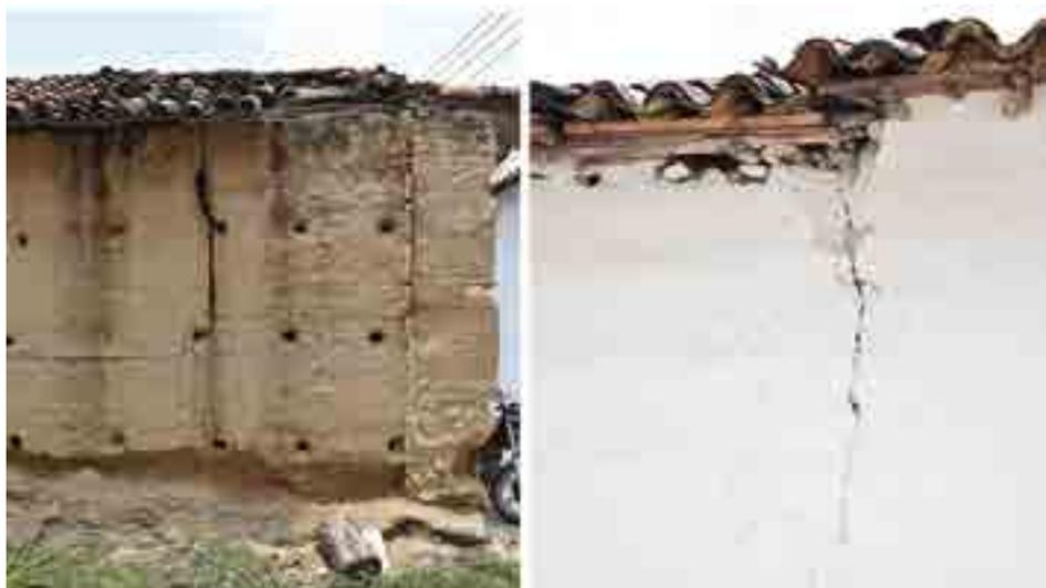
Lesioni e danneggiamenti dovuti alla troppa vicinanza tra edifici adiacenti costituiscono un problema molto comune negli edifici in terra. Quando avviene un terremoto, ogni edificio vibra in accordo con le proprie caratteristiche dinamiche e, di conseguenza, due edifici adiacenti possono dar luogo al fenomeno distruttivo del martellamento; in circostanze del genere, la posizione relativa degli orizzontamenti degli edifici adiacenti diventa rilevante (Di Pasquale et al, 2000).
