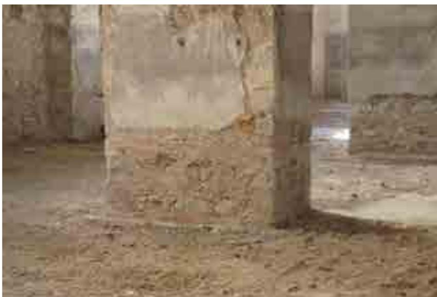
Figura 7. Particolare della muratura dei pilastri, Opus Listatum.
