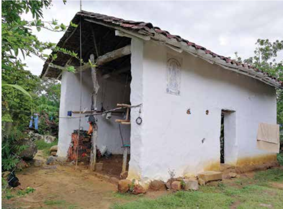
Figura 10. El caney está construido en tapia pisada, tiene una excelente manufactura y muy buen grado de conservación. Su forma y dimensiones permitirían adaptarlo a nuevos usos. Fuente: Autor.
