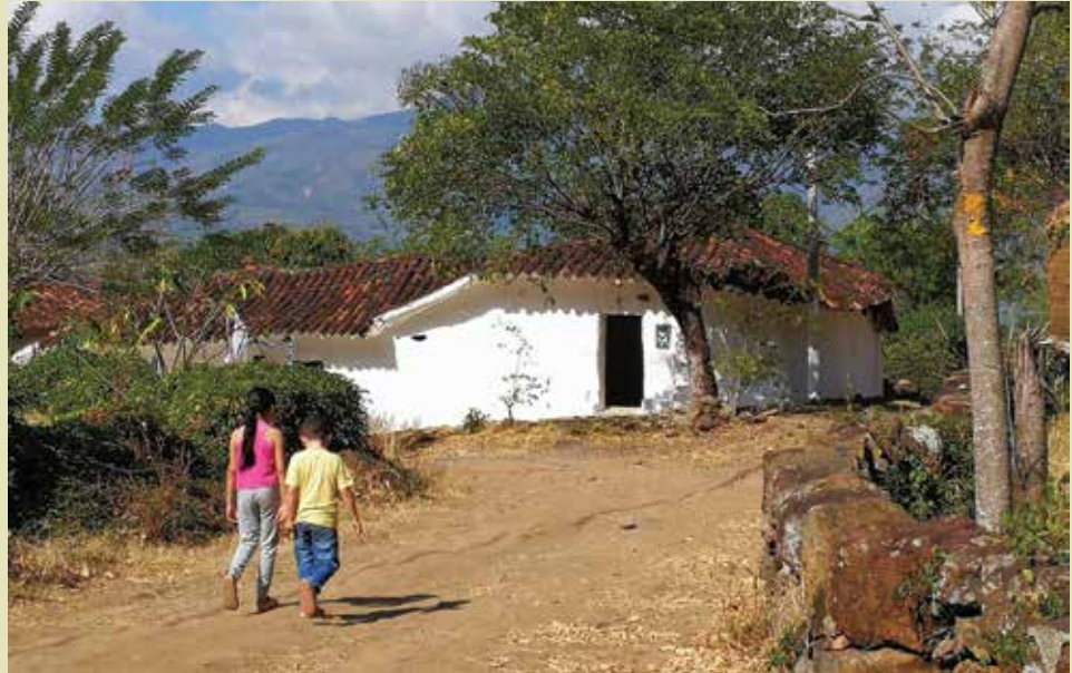
La "Casa Calderón y Monsalve" es representativa de la arquitectura vernácula en Cabrera, Santander. Fuente: Autor.
