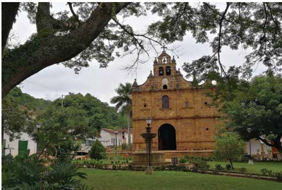
Figura 1. La Capilla de la Inmaculada Concepción es un ejemplo excepcional de la técnica de piedra tallada, contrario al uso de la tierra cruda presente en el resto de la arquitectura vernácula. Fuente: Autor.
