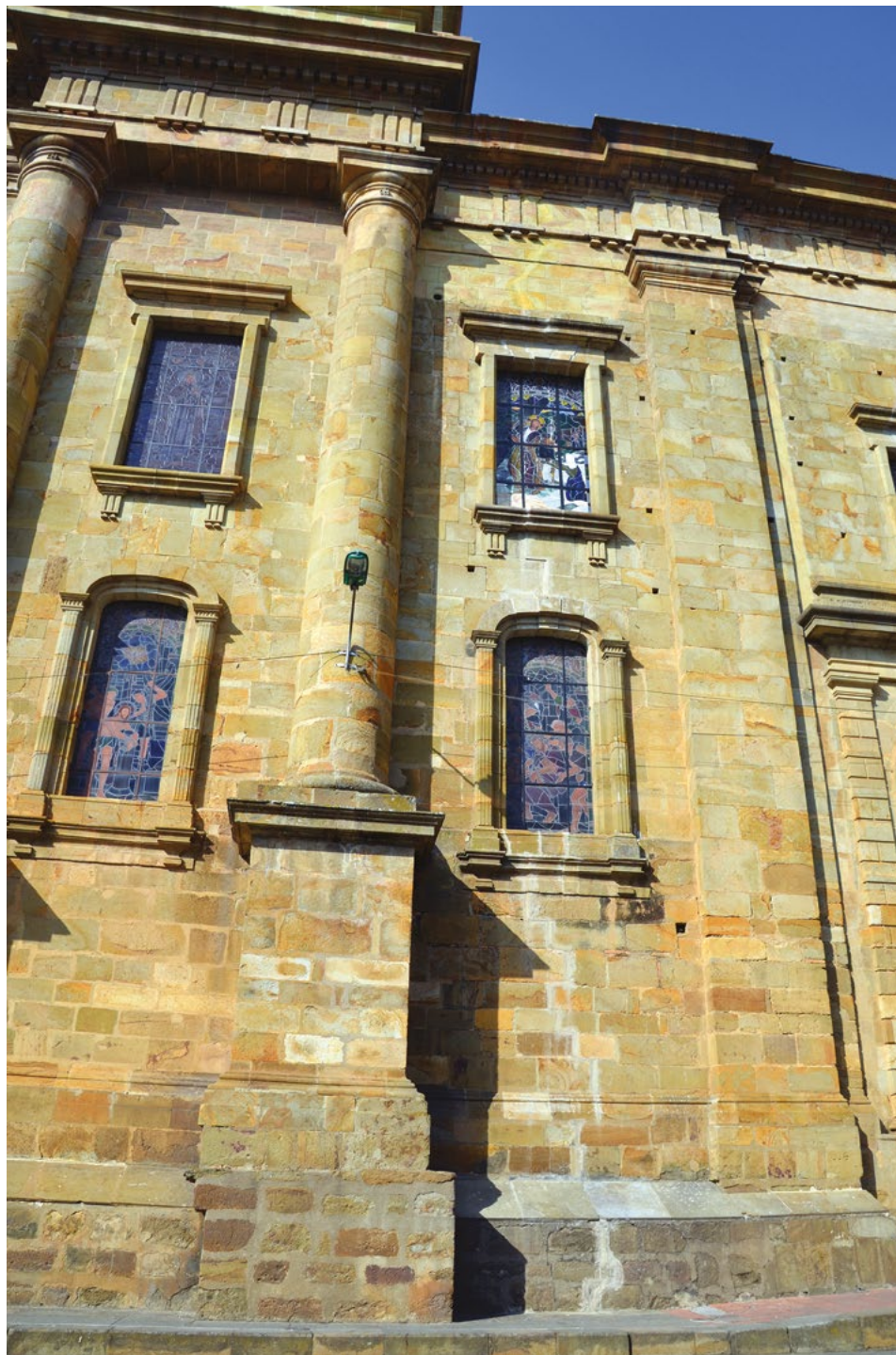
Figure 27. Stuccatura delle lesioni della facciata laterale della Basilica di Socorro Fonte: Michele Paradiso, 2018.
