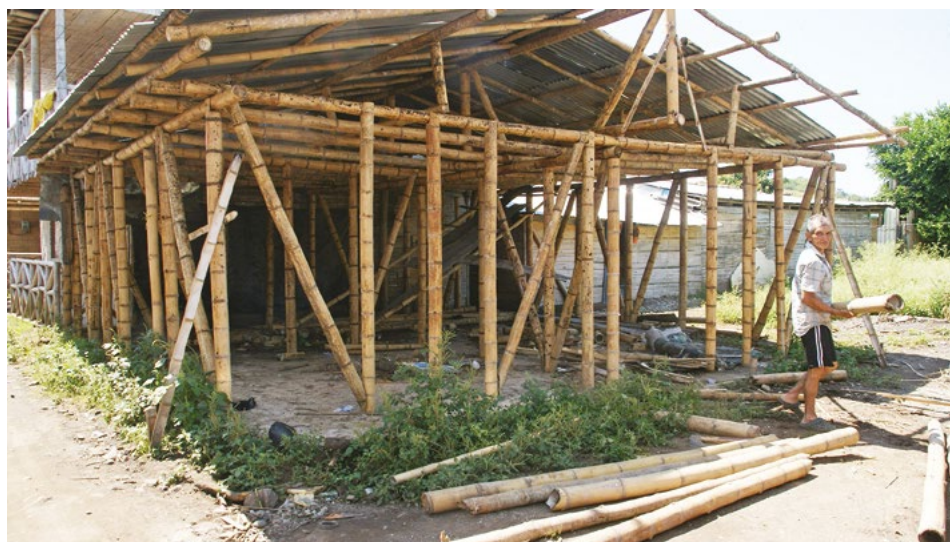
Figure 10. Cantiere di autocostruzione nell'asentamiento Nueva Esperanza Fonte: Valentina D'ippolito e Bianca Galmari, 2017.
