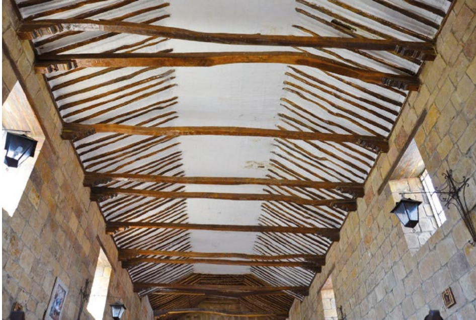
Figure 11. Struttura del tetto Fonte: Archivio degli autori, 2012.
