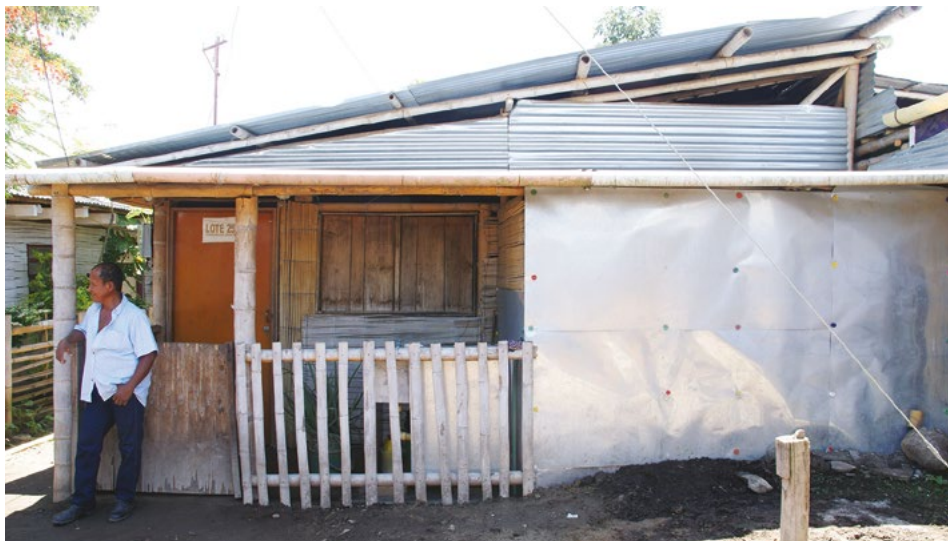
Figure 14. I rivestimenti metallici del Lote 251 Fonte: Valentina D'Ippolito e Bianca Galmarini, 2017.
