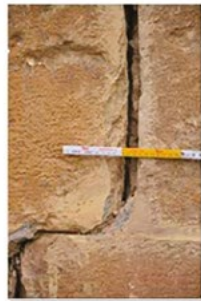
Figure 16. Ampiezza delle lesioni in facciata (2012) Fonte: Archivio degli autori, 2012.
