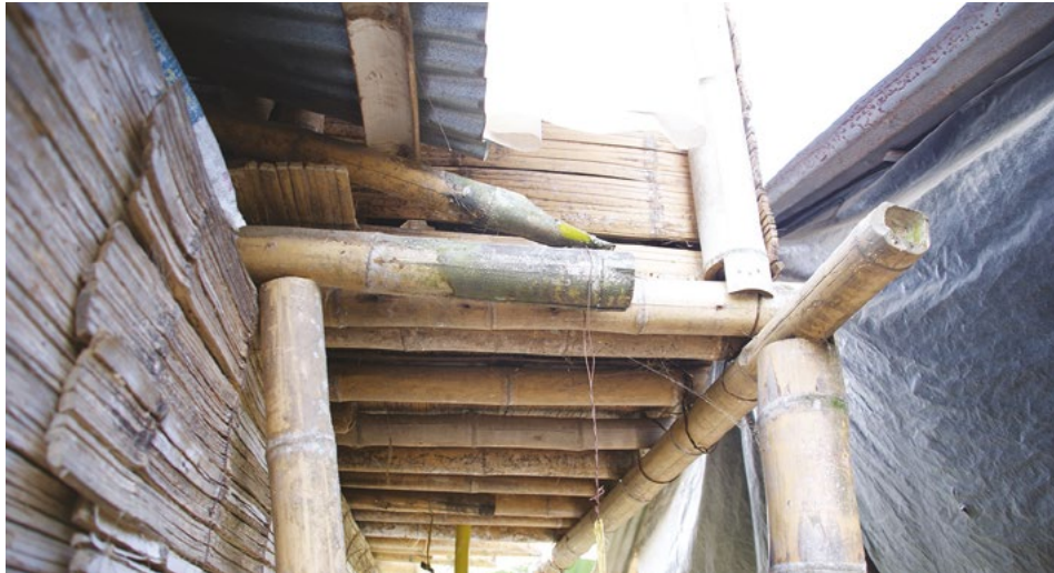
Figure 13. Errori di disegno e di collegamento degli elementi a sbalzo Fonte: Valentina D'Ippolito e Bianca Galmarini, 2017.
