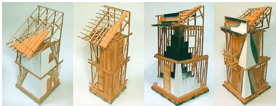
Figure 11. Le differenti tipologie di Bahareque: de Tierra, de Tabla, Metálico ed encementado Fonte: José Fernando Muñoz Robledo.
