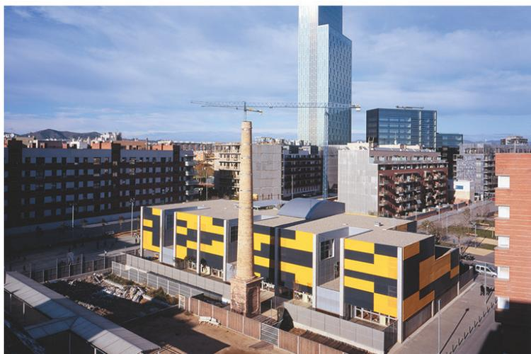
Figuras 11, 12, 13, y 14. Centro de Enseñanza Infantil y Primaria CEIP "Roc Blanc". Terrassa, España. Solución por combinación de sistemas constructivos pesados. Construcción industrializada con estructura y envoltorio de paneles de concreto. Figuras 11 y 12: Arquitecto Iván Acevedo Gómez. Fotografía 13: Nacho Alegre. Figura 14: Arquitecto Àlex Parella. Autores del Proyecto: Pich-Aguilera Architects. Colaboración proyecto, dirección y coordinación obra: Arquitecto Iván Acevedo Gómez
