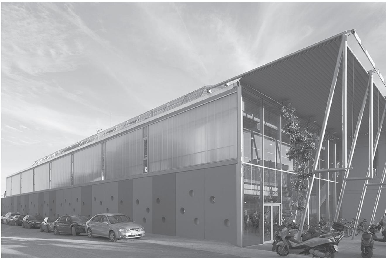
Figuras 20 y 21. Complejo Deportivo Municipal, "CEM Lleida" Lérida, España. Solución por combinación de sistemas constructivos pesados y ligeros. Construcción industrializada con estructura y envoltente de paneles de concreto combinada con paneles translúcidos. Fotografía: Inigo Ubeto e Iván Acevedo Gómez. Autores del Proyecto: Pich-Aguilera Architects. Dirección y coordinación del concurso, proyecto y obra: Arq. Iván Acevedo Gómez
