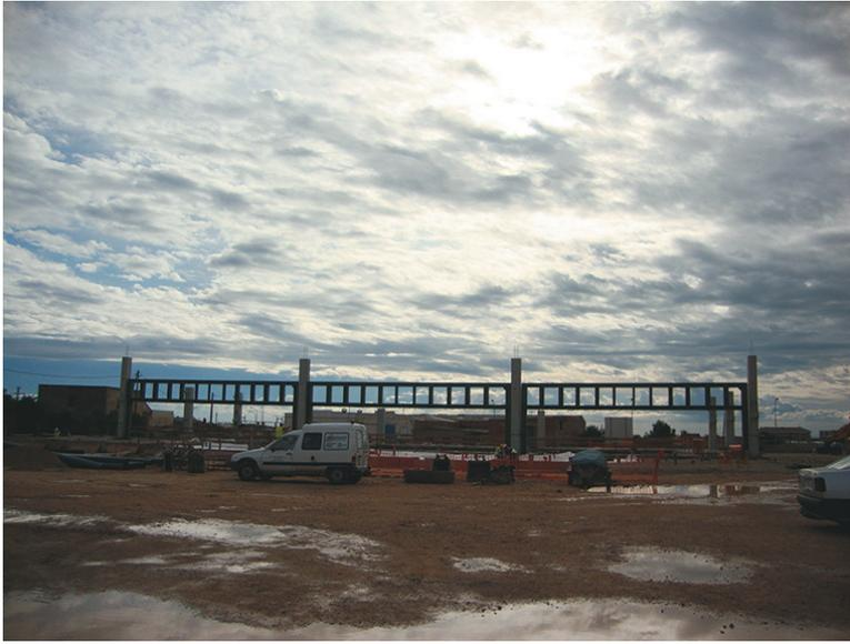
Figuras 17, 18 y 19. Complejo Deportivo Municipal, "CEM L'Ametlla de Mar". Tarragona, España. Solución por combinación de sistemas constructivos pesados y ligeros. Construcción industrializada con estructura y envoltente de paneles de concreto combinada con paneles translúcidos. Fotografías: Arquitecto Iván Acevedo Gómez. Autores del Proyecto: Pich-Aguilera Architects. Dirección y coordinación del concurso, proyecto y obra: Arquitecto Iván Acevedo Gómez
