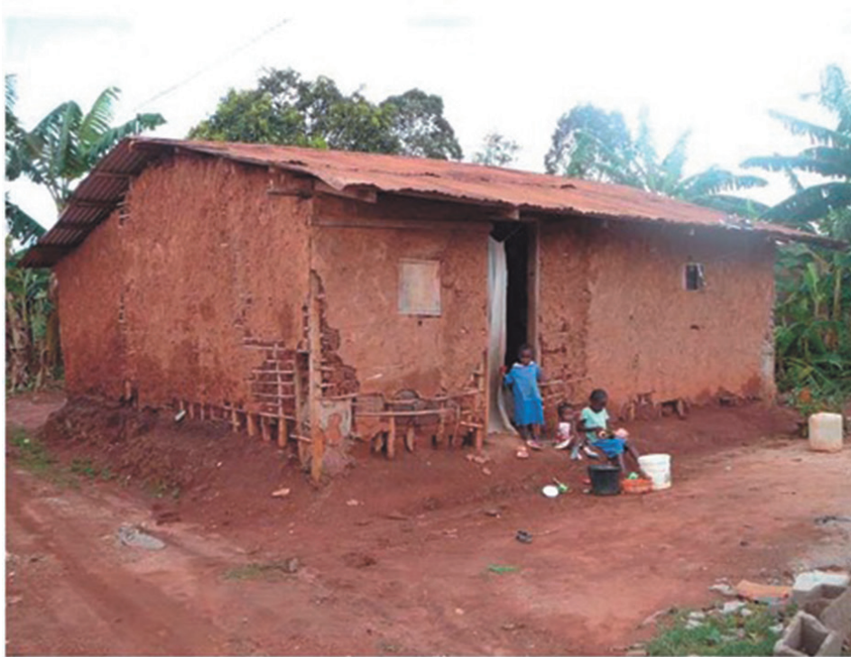
Figura 1. Condiciones de vivienda y letrinas en Yaoundé, Camerún. Fuente: Información suministrada dentro de las bases del concurso internacional Building Malaria Prevention por la organización Archive Global Architecture for Health.
