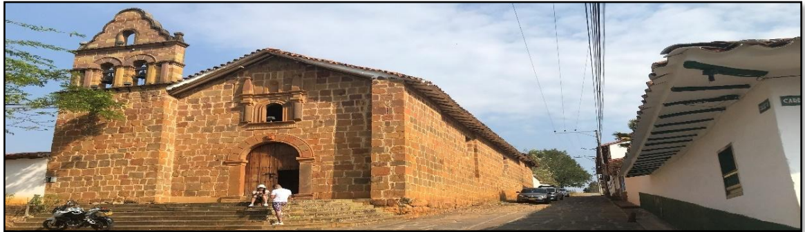
Vista Fachada principal iglesia de Santa Bárbara, Barichara. Fuente: Yolanda Blanco Vesga
