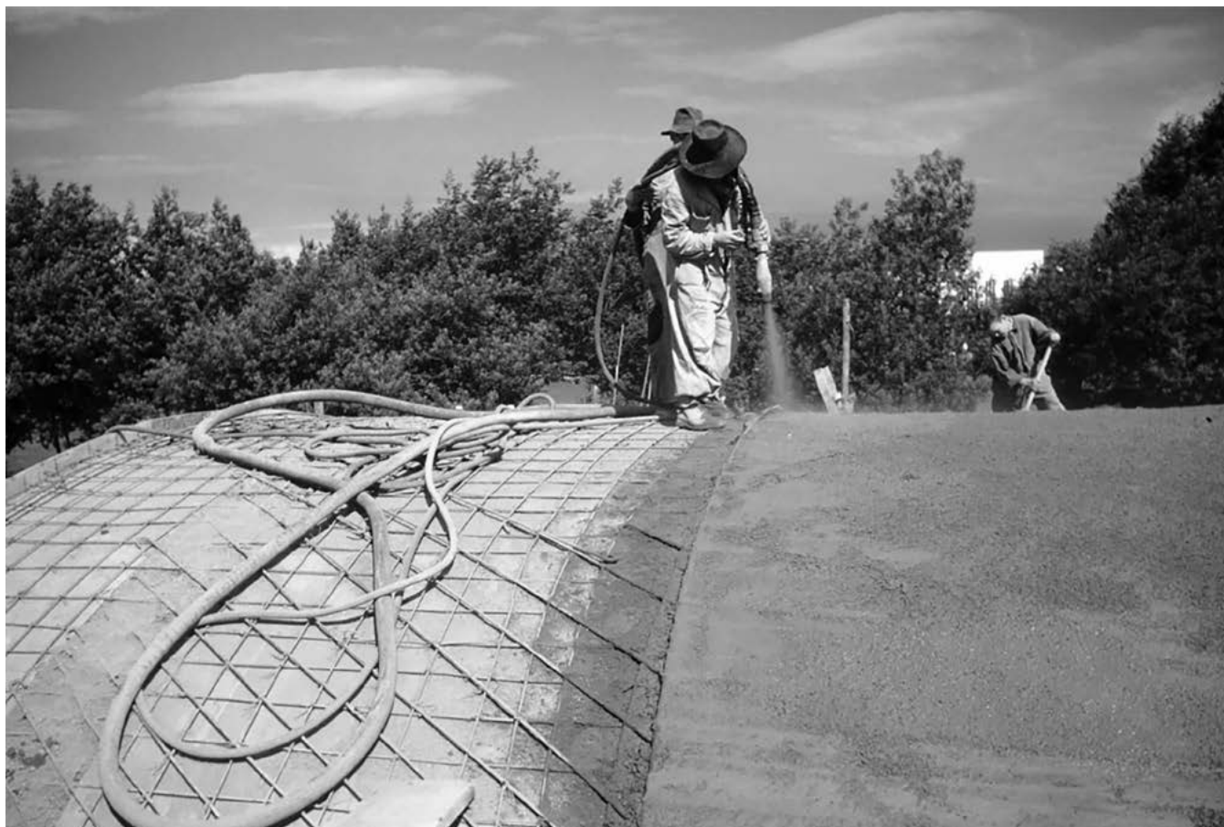
Figura 8. Hormigón proyectado sobre los encofrados de las membranas del edificio CINVA, 1953.
