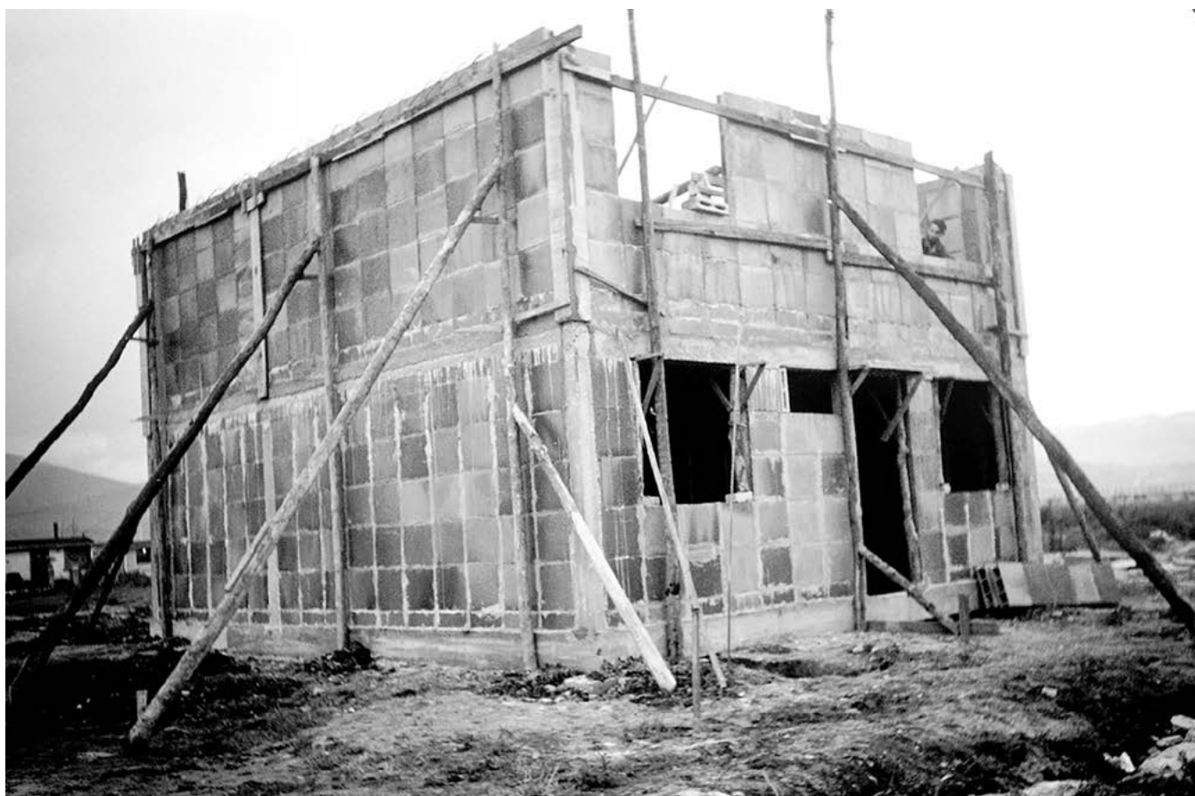
Figura 9. Vista de la casa experimental para la urbanización Torcoroma, a partir de paneles prefabricados utilizando bloques cerámicos. Fuente: Eyhéralde, 1954, p. 51.
