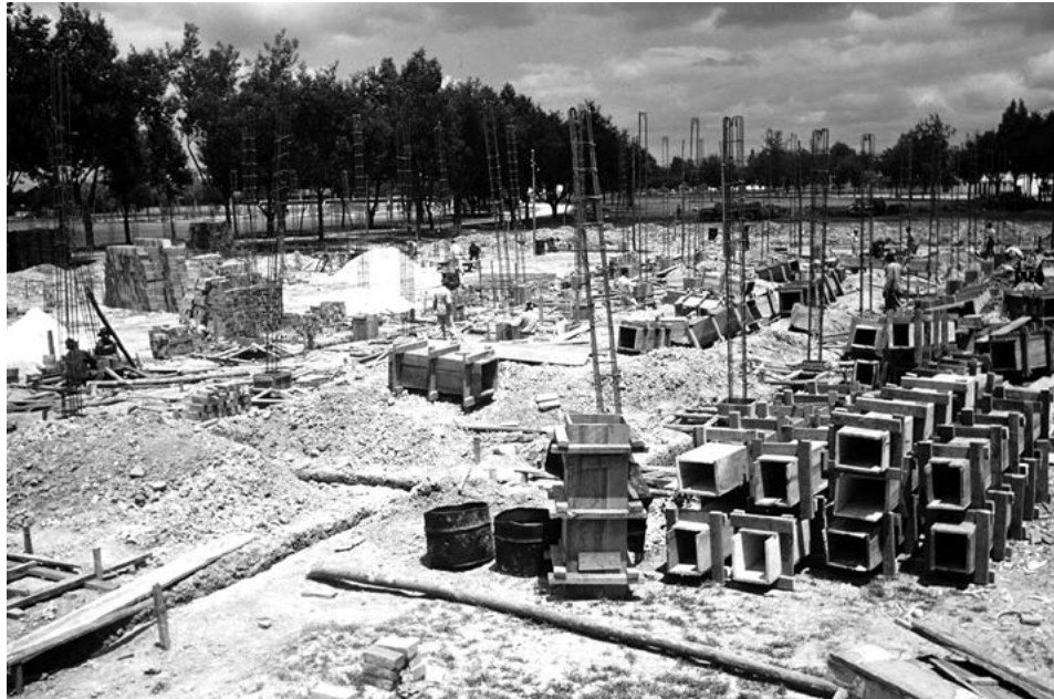
Figura 6. Inicio de la fundición de columnas para la sede del CINVA. Fuente: Currie, L. J., 1913-1996 (photographer), CINVA (Inter-American Housing and Planning Center), Bogotá, Southwest Virginia Digital Archive.
