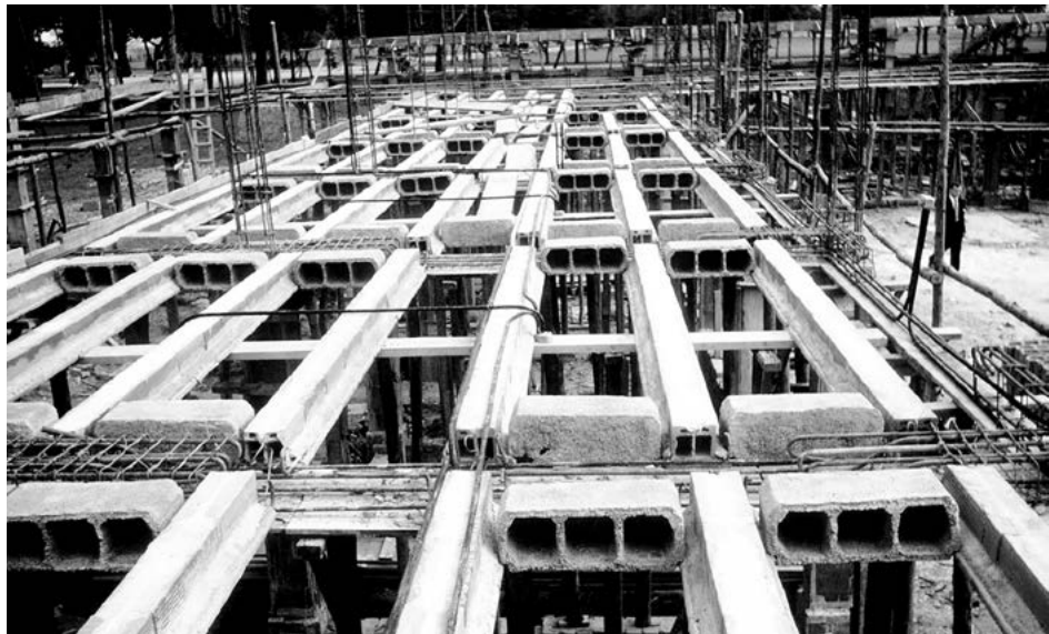
Figura 7. Vista general de la construcción de sistemas de entrepiso en el edificio sede del CINVA. Fuente: Currie, L. J., 1913-1996 (photographer), CINVA (Inter-American Housing and Planning Center), Bogotá, Southwest Virginia Digital Archive.
