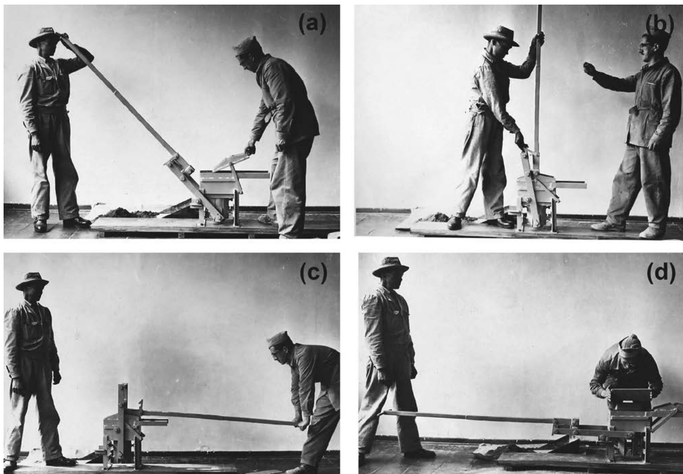
Figura 10. Secuencia demostrativa del uso de la máquina Cinva-Ram.
