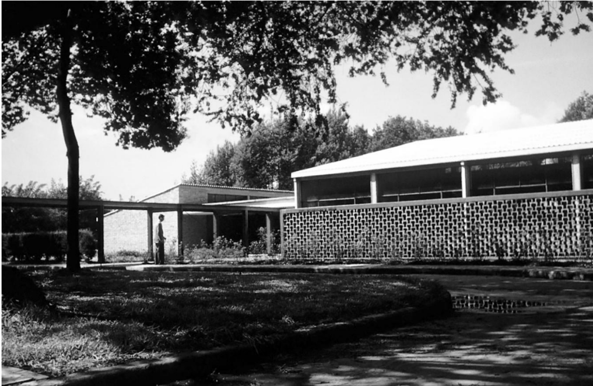
Figura 5. Vista parcial de la fachada exterior que mira al oriente y pérgola sobre la entrada principal en la sede del CINVA, diciembre de 1954. Fuente: Currie, Leonard J. (Leonard James), 1913-1996 (Photographer), "CINVA (Inter-American Housing and Planning Center), Bogotá, Southwest Virginia Digital Archive, accessed June 9, 2022, https://di.lib.vt.edu.items/show/679 .
