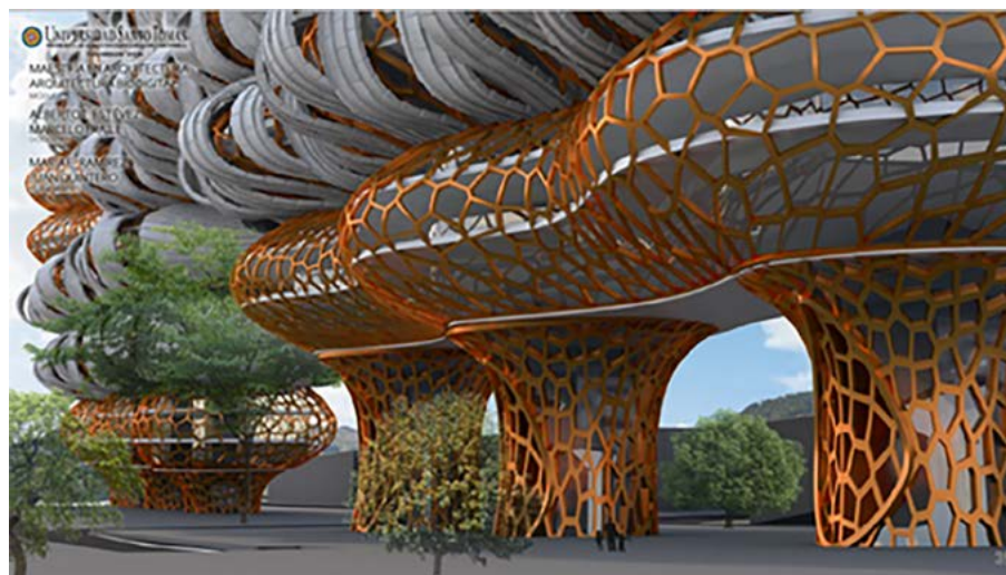
Figura 3. Detalle planta baja y pilares de soporte Fuente: Proyecto de María E. Ramírez y Juan Quintero.
