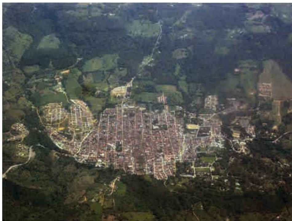
Figure 2. Veduta aerea di Socorro. E' evidente la caratteristica reticolare urbana degli insediamenti spagnoli della Colonia. Fonte: www.mapio.net .
