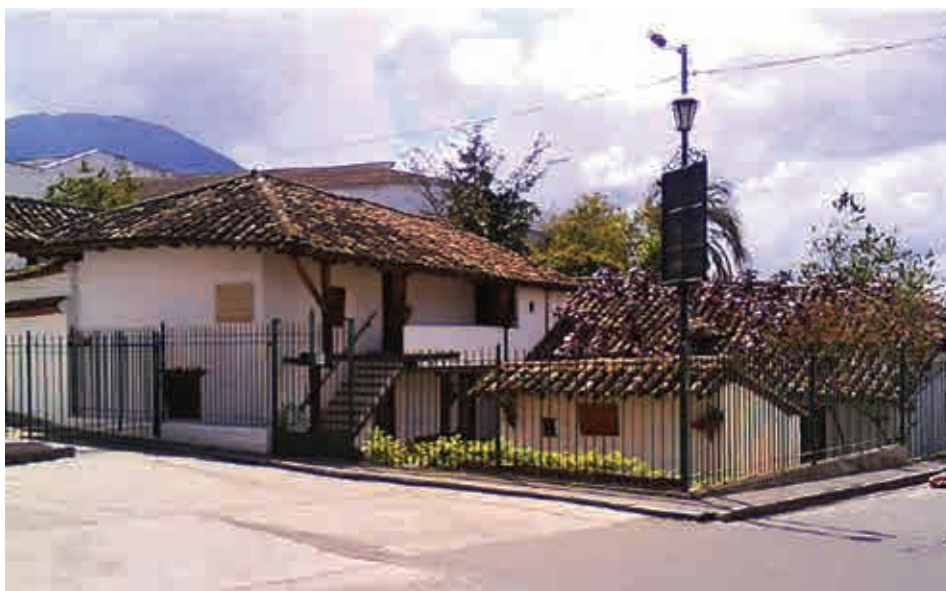
Figura 6. Estado actual de la Casona Taminango
