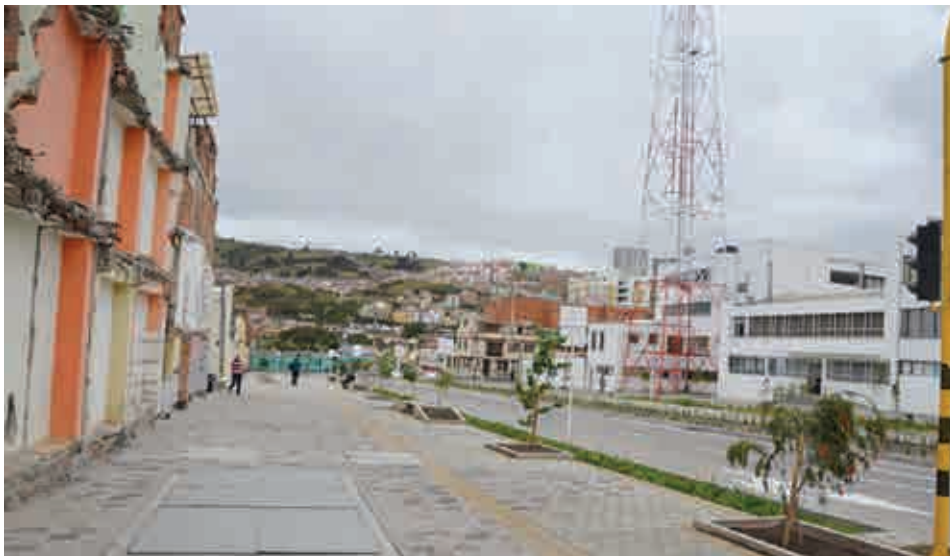
Figura 9. Panorámica parcial de la Carrera 27. A la izquierda se aprecian las acciones de demolición, infligidas al espacio privado Fuente: Michele Paradiso, 2016
