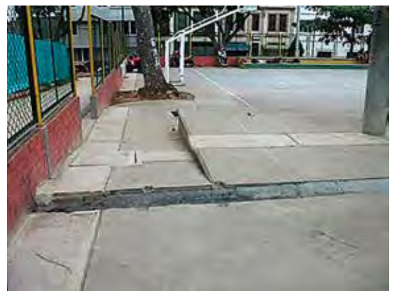
Figura 7. Canal de aguas lluvias. Fuente: Leonardo Enrique Díaz Suárez, 2015.
