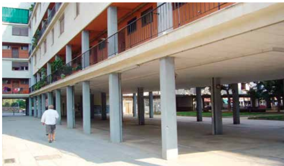
Figura 1. Josep Lluís Sert, Josep Torres Clavé, La Casa Bloc en Barcelona, España, 1932. Los pilotes de la planta baja permiten una total permeabilidad entre las dos plazas. Fuente: Luca Bullaro, 2015.
