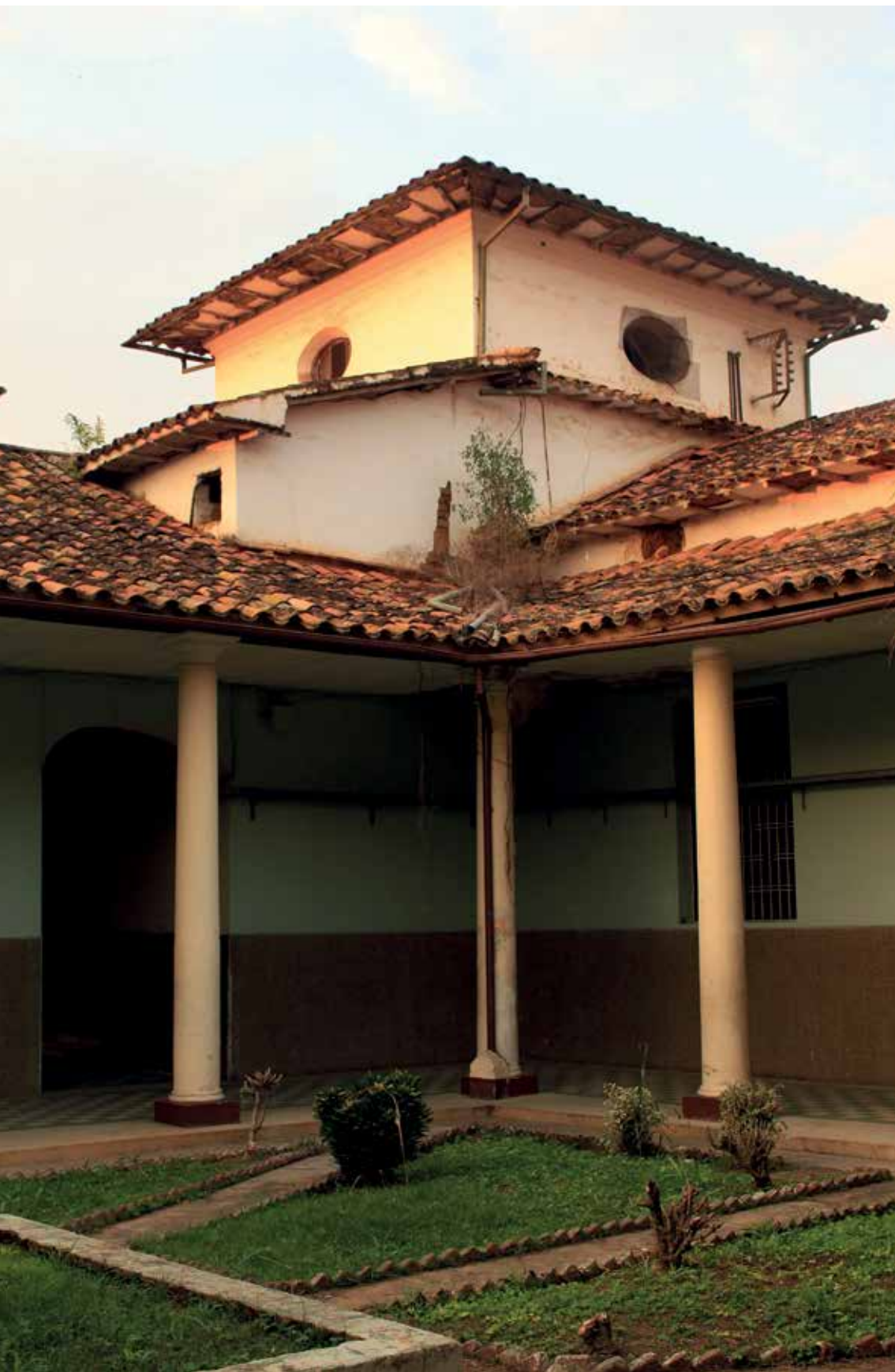
Figura 2. Interior del antiguo Hospital San Juan de Dios de Bucaramanga Fuente: Román Perdomo, 2014
