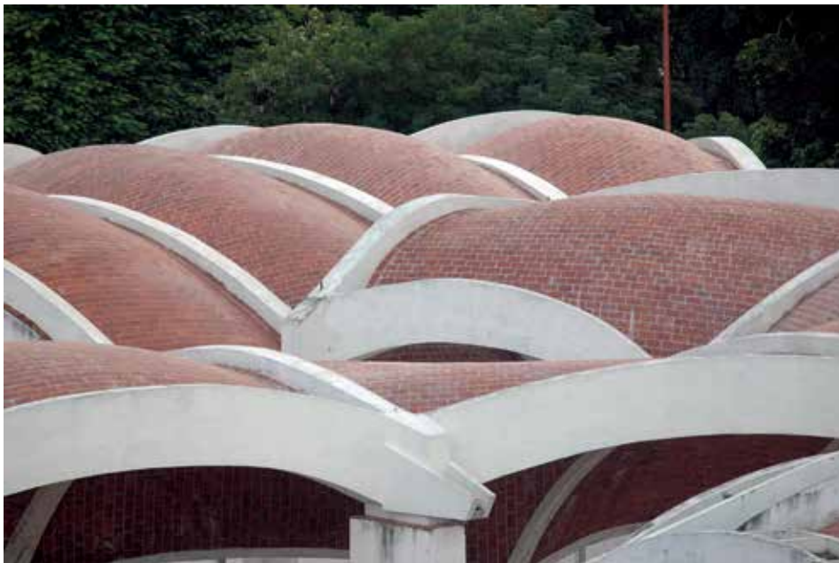
Figura 8. Scuola di Danza, restaurata, particolare. Fonte: Arch. Michele Paradiso.
