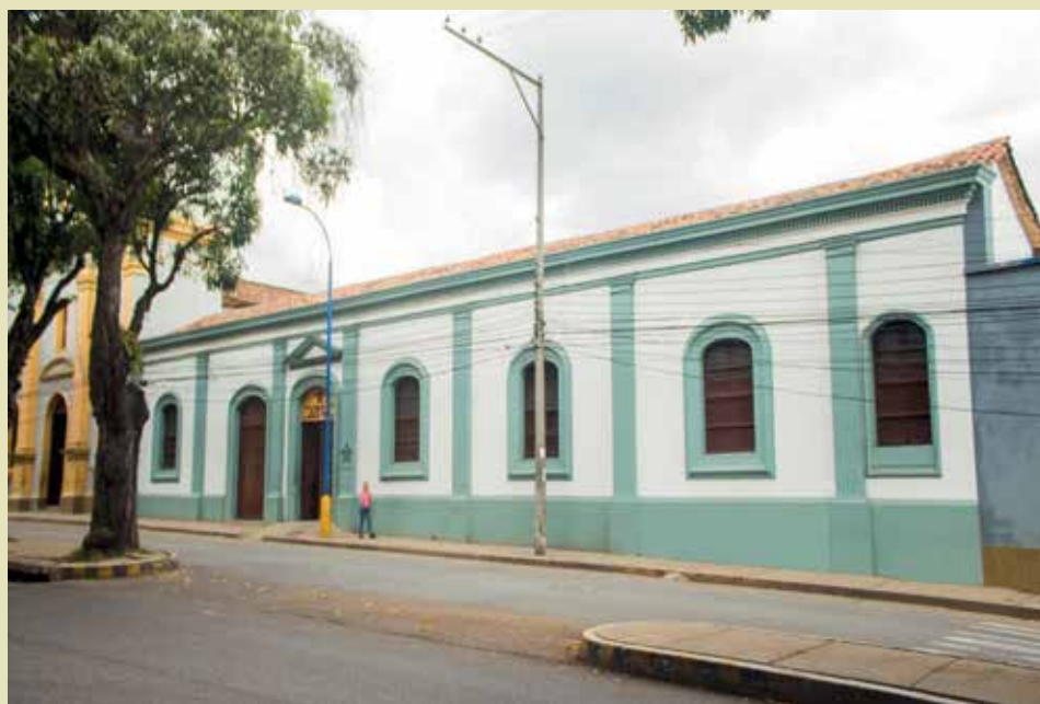
Fachada del edificio del antiguo Hospital San Juan de Dios Fuente: Román Perdomo, 2014.
