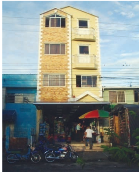
Imagen 30. Conjunto de fotografías que revelan el estado de los predios
