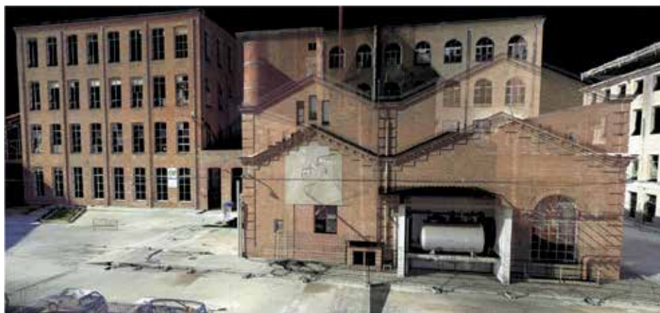
Figura 1. Levantamiento TLS, perspectiva nube de puntos Fabra i Coats Fuente: Elaboración propia de los autores.
