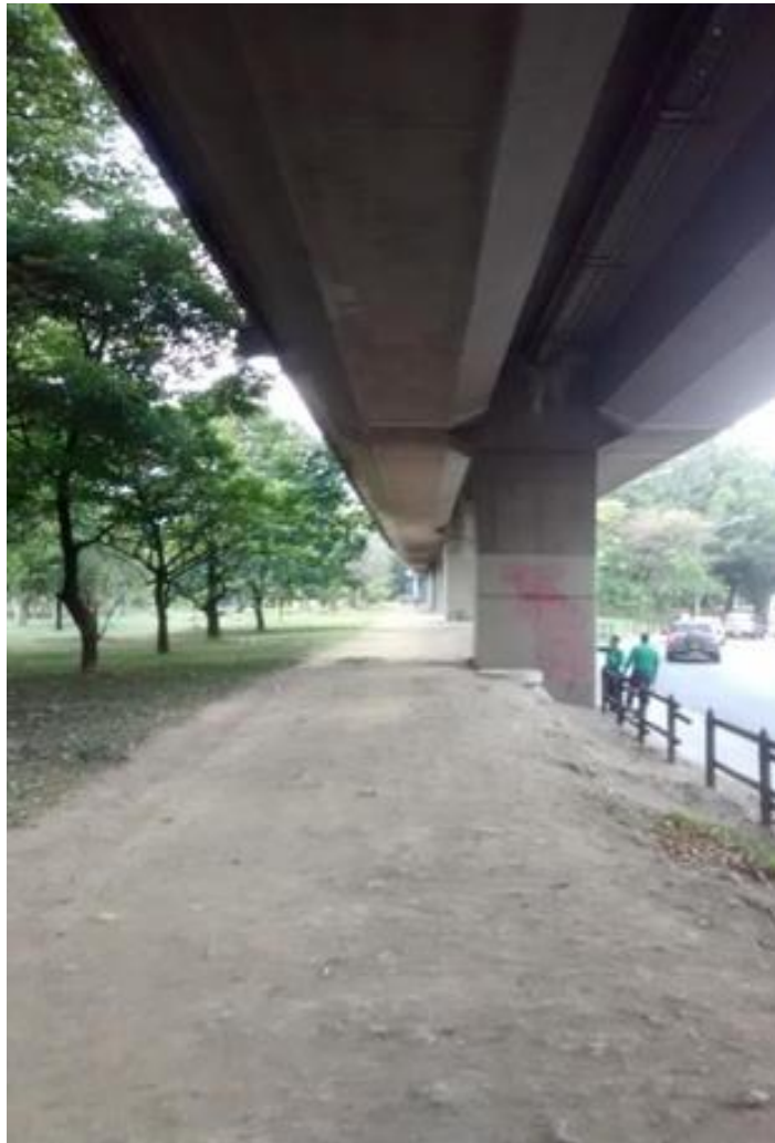
Figura 5. La zona de circulación peatonal actual, debajo el viaducto del Metro.
