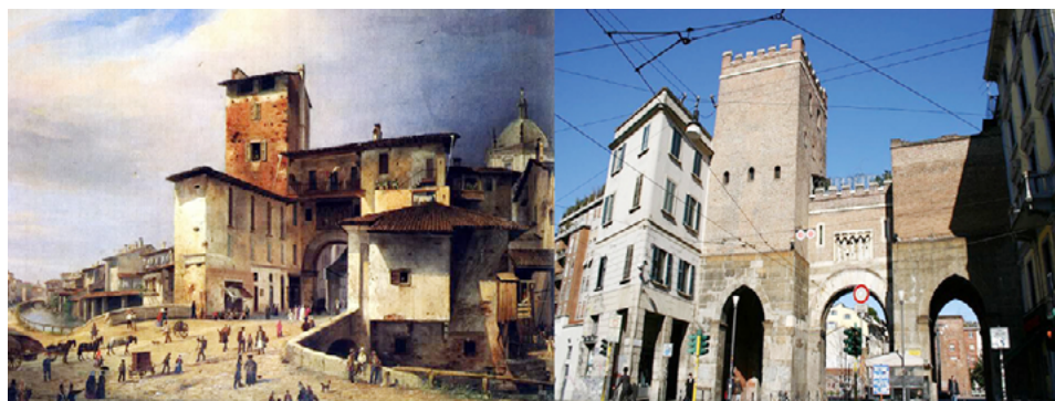
Figura 7. Porta Ticinese. Antes y después de la intervención de Boito. El aspecto actual de la puerta medieval de Milán (vista aquí desde el Corso di Porta Ticinese) se debe a la reconstrucción neogótica de 1865, basada en un proyecto del arquitecto. Fuente: Carlos Humberto Gómez Arciniegas.
