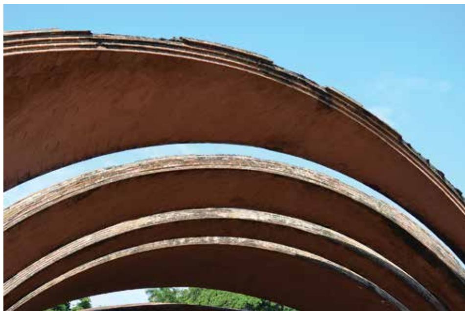
Figura 4. Volte catalane dell'entrata della Scuola di Balletto di Vittorio Garatti: sono visibili le perdite di rasillas in estradosso. Fonte: Foto di Michele Paradiso, 2016.
