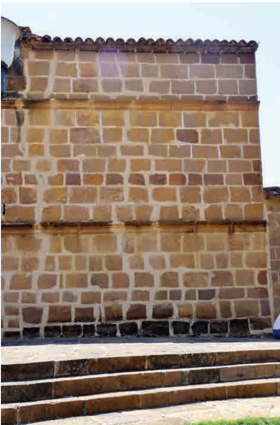
Figure 25. Ristuccatura delle lesioni in facciata Fonte: Archivio degli autori, 2018.
