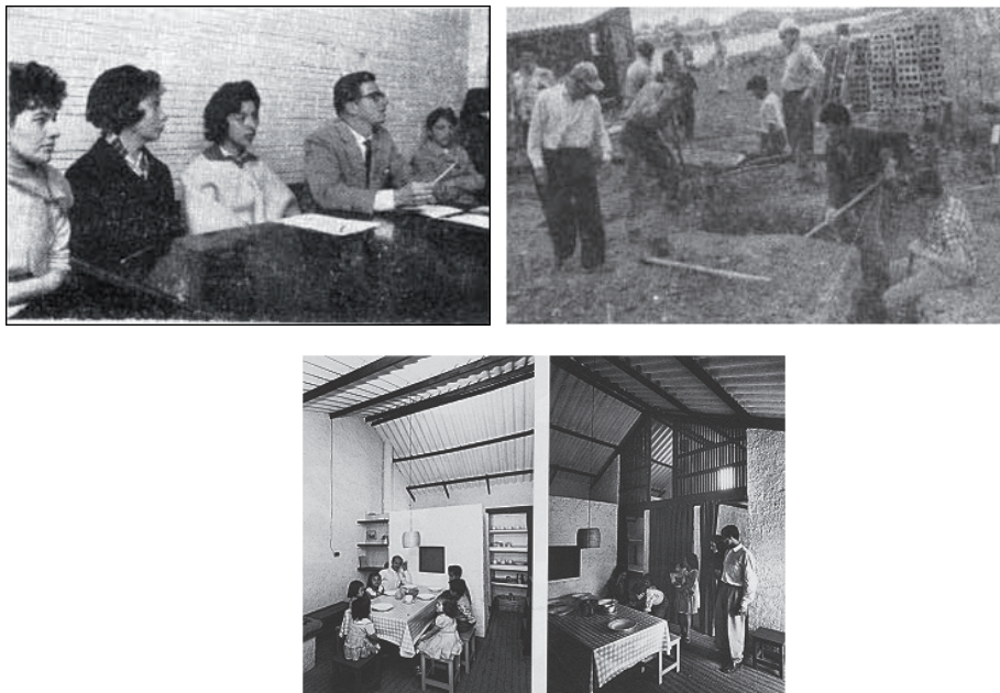
Fig. 06 la-b- 062 -Proyectos de Vivienda la Fragua y Quirigua.
