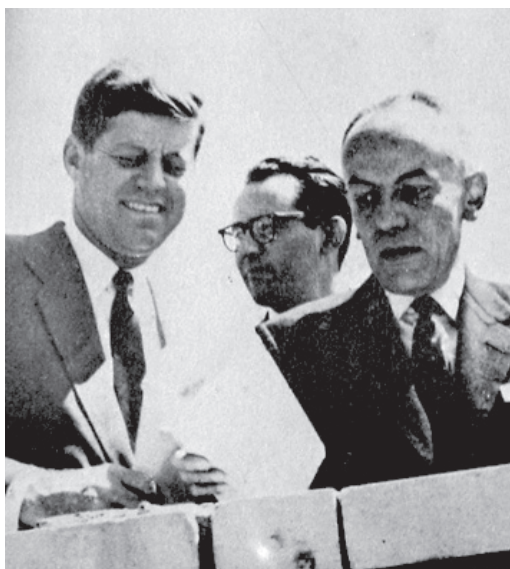
Fig.010. Programa de Asistencia económica y social “Alianza Para el Progreso” Colocación del primer ladrillo de Ciudad Techo-John F. Kennedy & Alberto Lleras.
