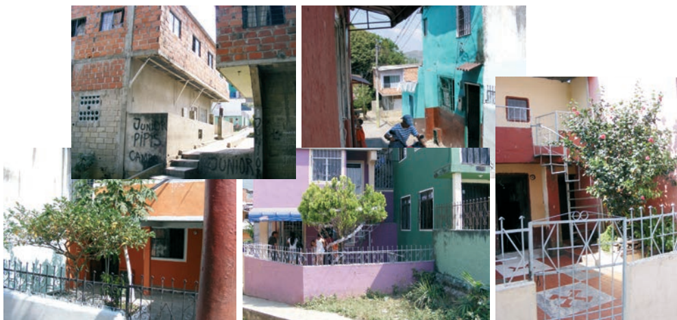
Fig. 11. Vistas paisajísticas del estado del proceso de consolidación 25 años después. El proceso de construcción iniciado en 1983 de la unidad mínima por parte del ICT Instituto de Crédito Territorial, ha sido continuado por autoconstrucción por cada propietario. Esto le añade variaciones formales tectónicas al esquema topológico inicial. Las variables económicas explican el mayor o menor desarrollo de cada unidad domiciliaria. El uso inicial habitacional se mantiene y sólo algunos módulos han sido transformados en comercio zonal. No aparece el uso de los patios como interiores comunes como zona de talleres, a diferencia de lo que sucede en barrios de desarrollo urbano convencional en otras zonas de la ciudad.
