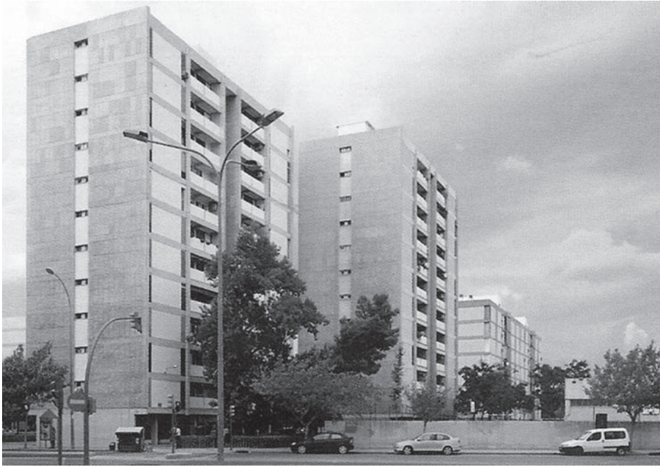
Figura 3.28. Tipo C12-4, vista exterior de las dos torres
