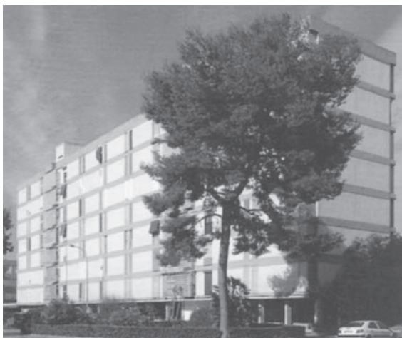
Figura 3.18. Tipo A8-3, vista de la unidad
