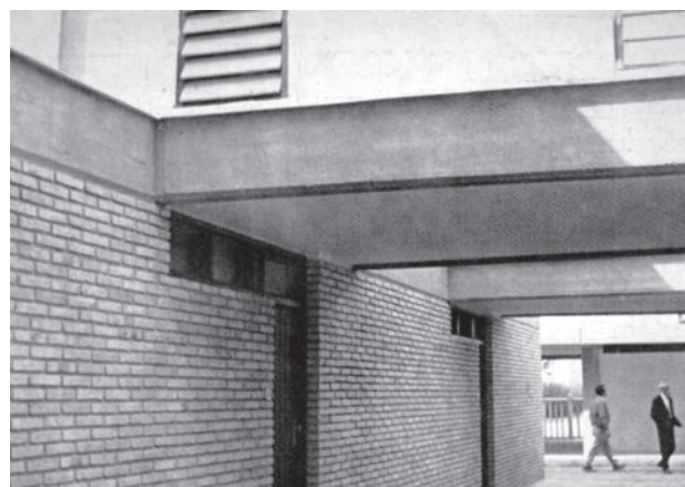
Figura 3.25. Tipo B2-3, vista de la calle interior y de los huecos de los dormitorios
